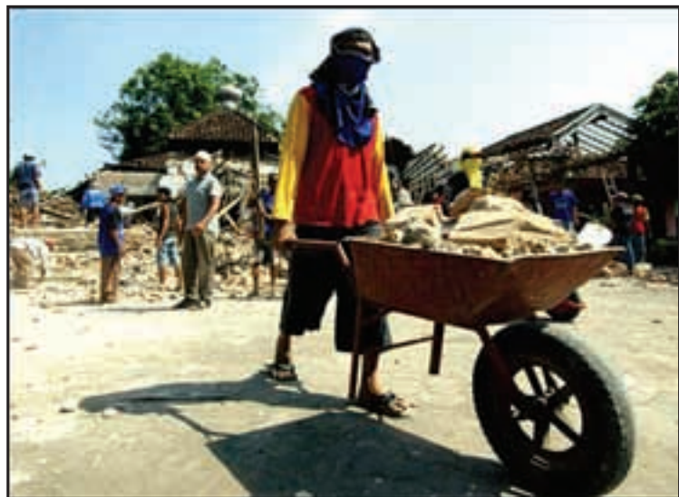
Boluntarionan ta traha pa haci limpiesa y reconstrui un meskita na Bantul.
